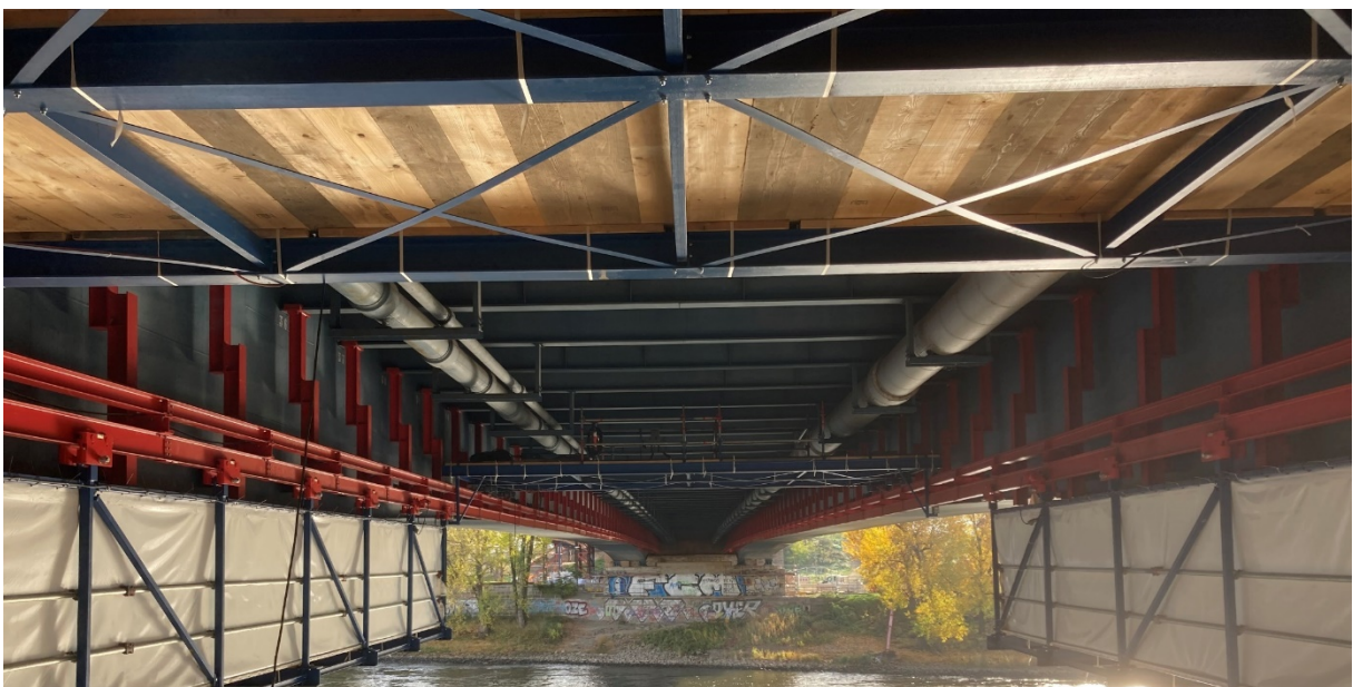
Abb. 12: Untersicht Überbau mit temporären Schienenkonstruktion für die Verfahrenanlage sowie Arbeitsbühnen
