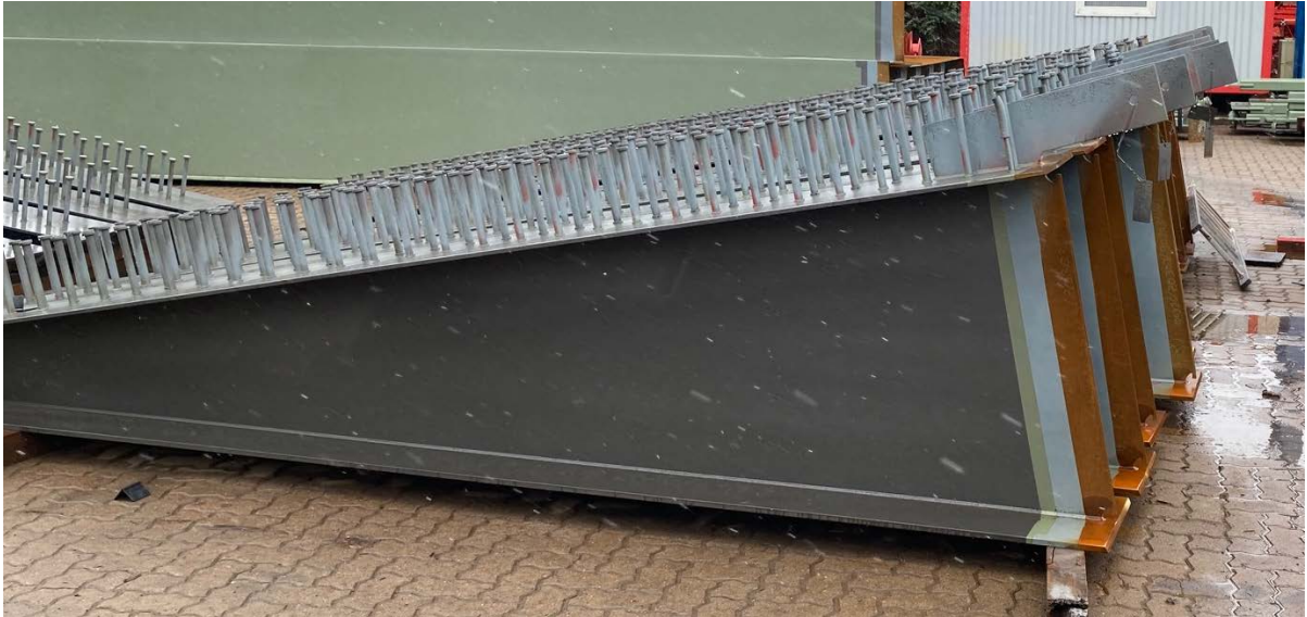
Abb. 7: Rad- und Gehwege als fertige Bauteile der Zoll-Elbe Brücke
