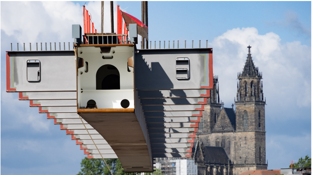
Abb. 8: Einheben der Hauptträger auf der Baustelle
