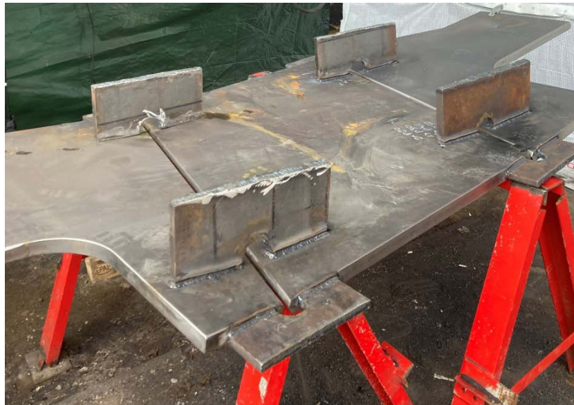
Abb. 14: Schweißen der am Bestand angepassten Lamellen im Bereich der Auflagervoute
