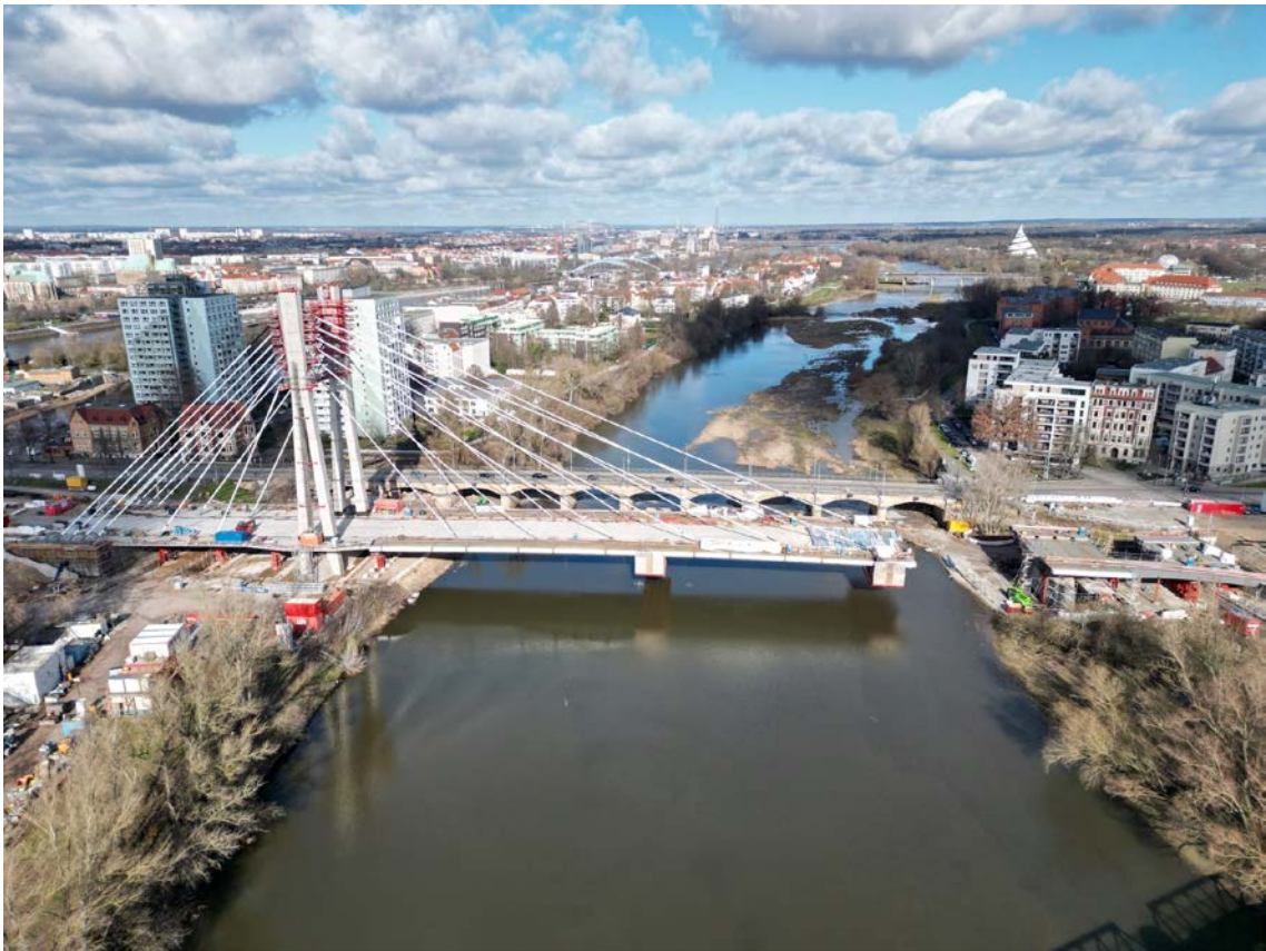
Abb. 20: Fertiger Freivorbau bis Schuss 6 und Seitenfeld Ost
