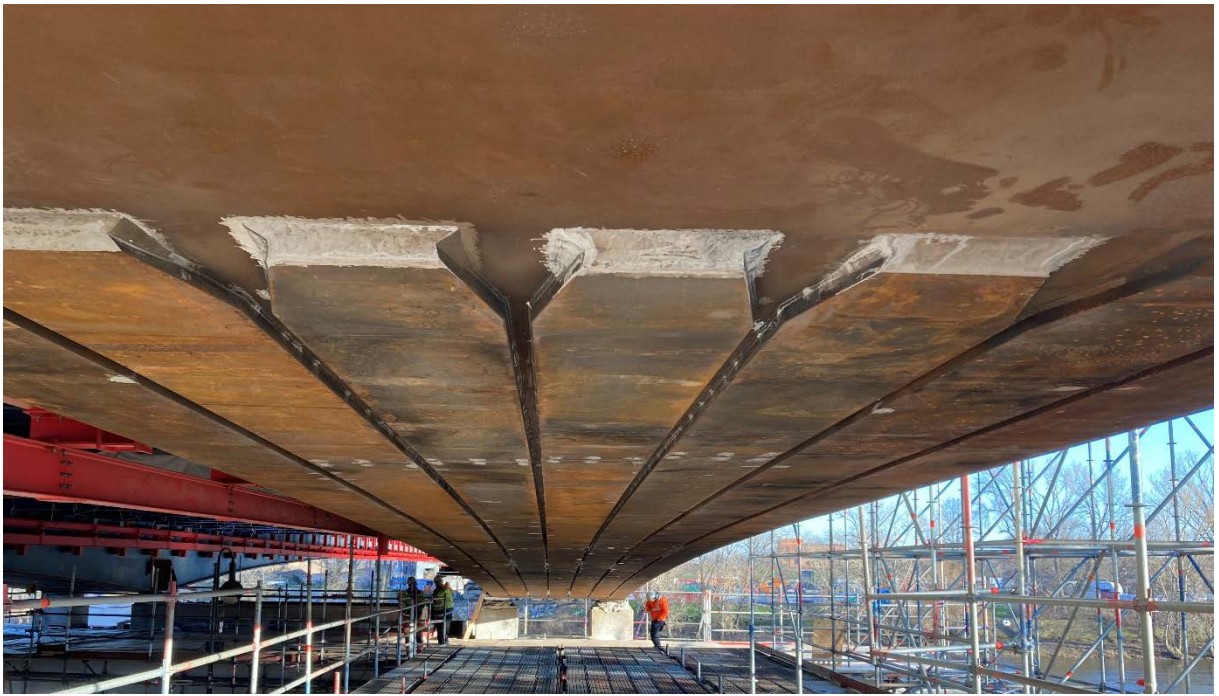
Abb. 16: Fertig hergestellte Hohlkastenverstärkung bestehend aus 7 Lamellen
