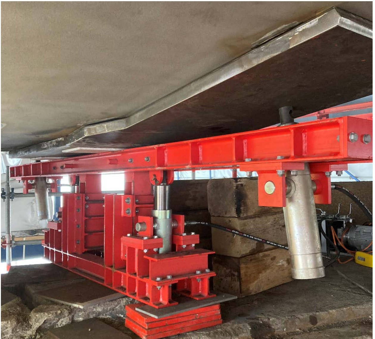
Abb. 13: Pressenbock am Widerlager zum Andrücken der Blechlamellen an der Voute
