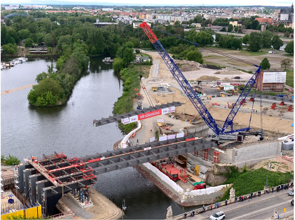
Abb. 9: Einheben der Hauptträger auf der Baustelle II
